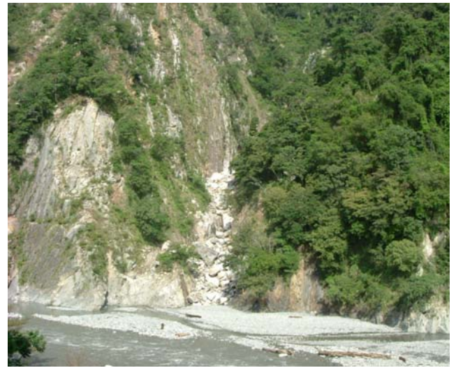
圖 1-23 山區溪谷坡度陡峭易氾濫成災
