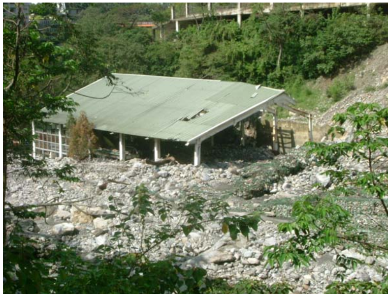
圖 1-25 溪邊河床搭建房舍與水爭地
