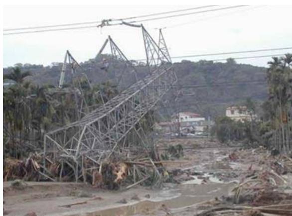
圖 1-17 狂風吹毀房屋及電力設備
